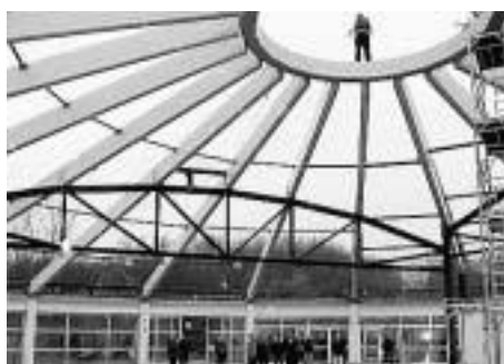
Das Ex-Wellenbad bekommt ein neues Dach, wird eine Veranstaltungshalle.
