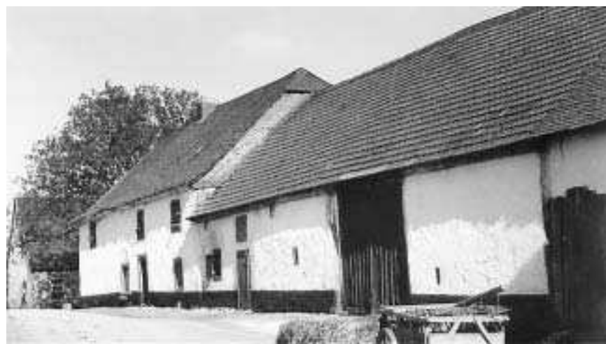
Fränze Haus im Reiterbruch, um 1865 erbaut, existiert nicht mehr.
