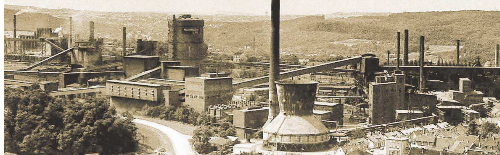
Schornsteine, Rohre überall – die Hütte beherrschte das Bild der Stadt. Heute gibt es hiervon nur noch den Gasometer.
