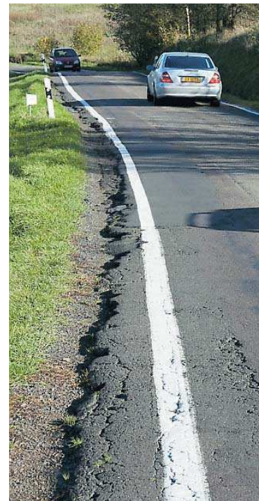
Die Landstraße L 322 zwischen Wolfersweiler und Walhausen wird saniert. Foto: SZ
