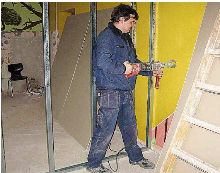
Der Innenausbau ist bereits in vollem Gange.
