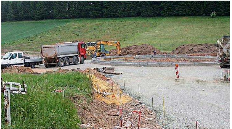
Am Gonneseweiler Kreislauf wird noch gebaut . FOTO: GEMEINDE
