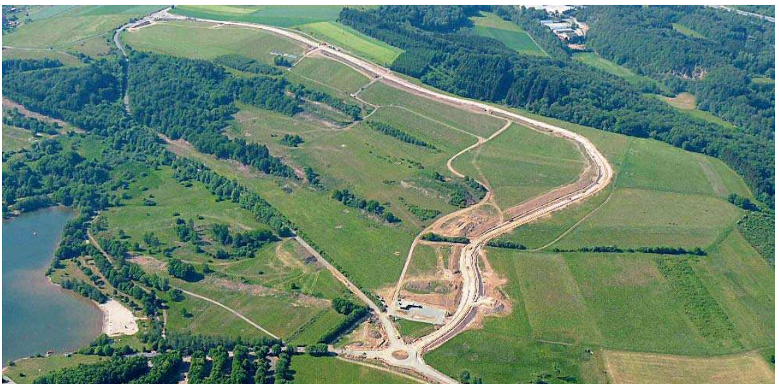
Blick von oben auf das Ferienparkgelände am Bostalsee. Deutlich zu erkennen ist die helle Trasse der neuen Zufahrtsstraße und der Kreislauf bei Gonneseweiler. FOTO: PROJEKTGESELLSCHAFT
