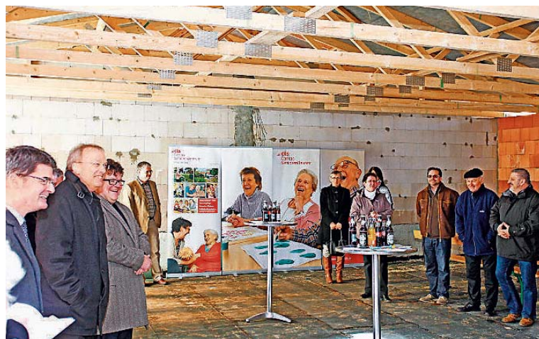
Die Gäste treffen sich zum Richtfest im Rohbau.
