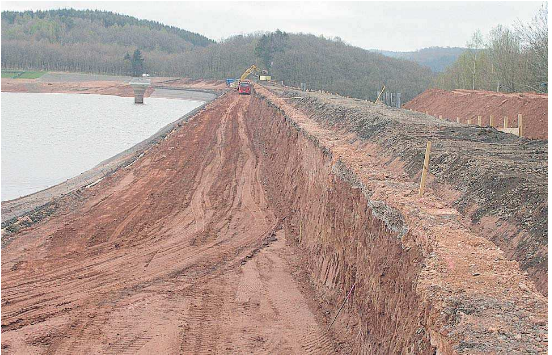
Drei Meter tief graben die Bagger den Damm zur Seeseite hin bis zur Betonmauer ab.
