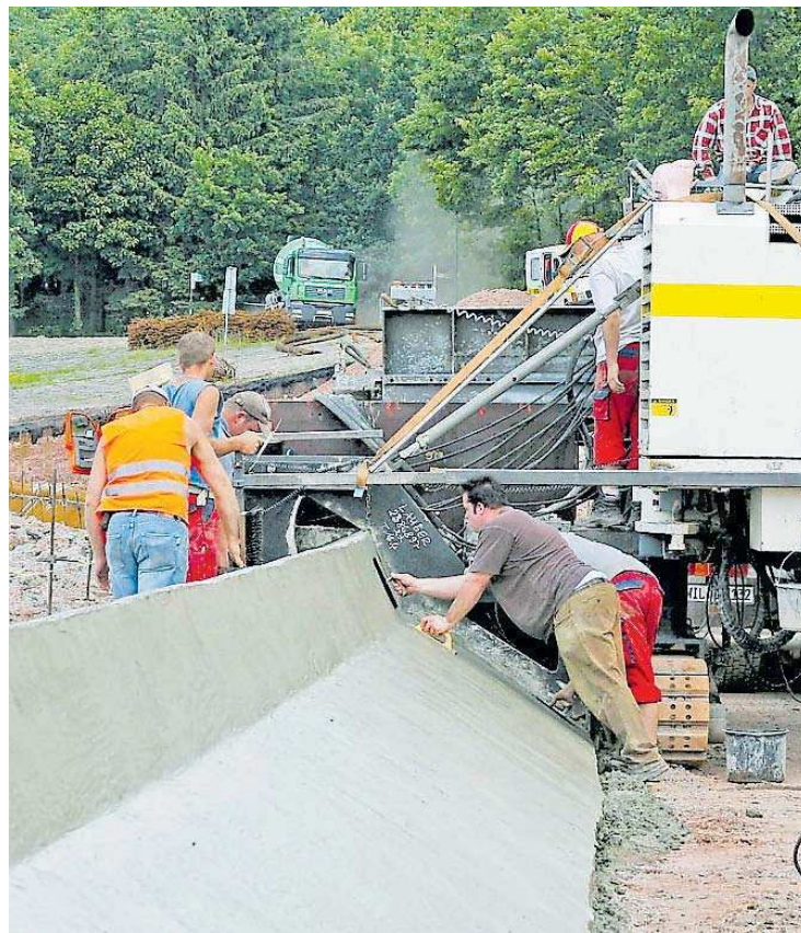
Arbeiter glätten hinter der Spezialmaschine noch ein wenig die Mauer aus wasserdichtem Beton.
