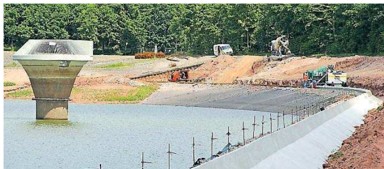
In nur wenigen Tagen ist die neue Mauer entstanden.
